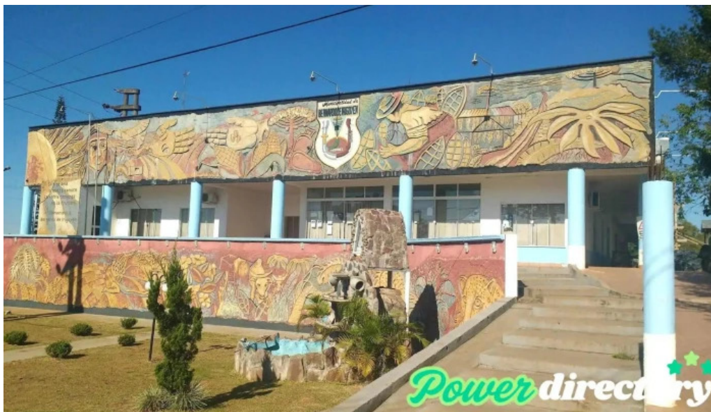
Municipalidad de bernardo de irigoyen edificio
