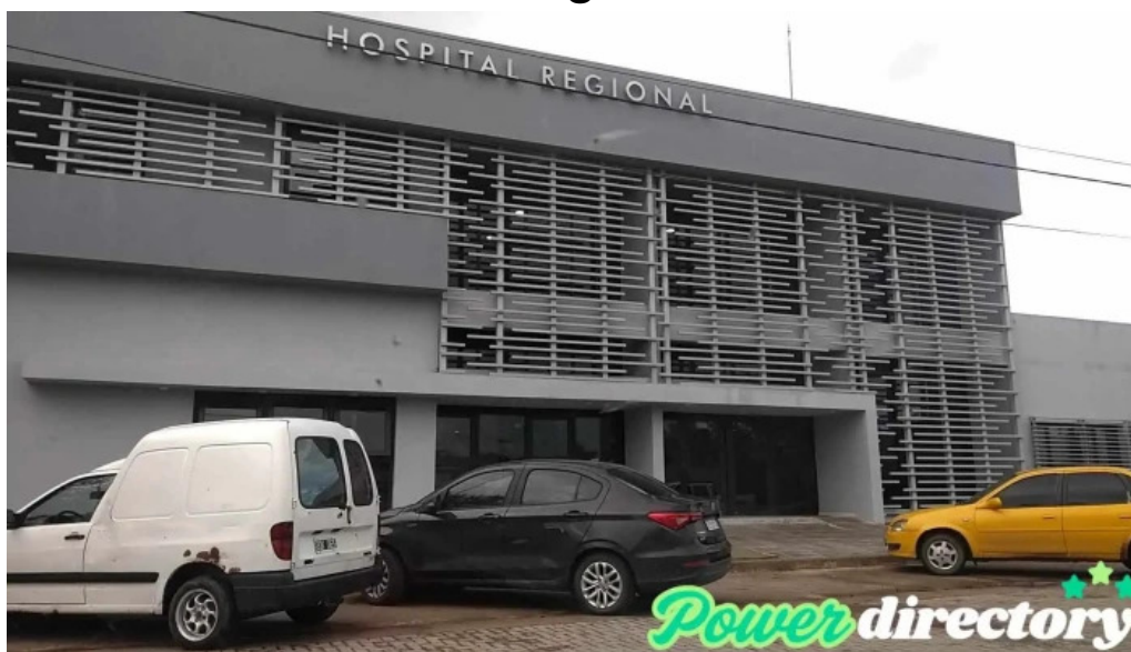
Hospital san jose de la dormida san jose de la dormida
