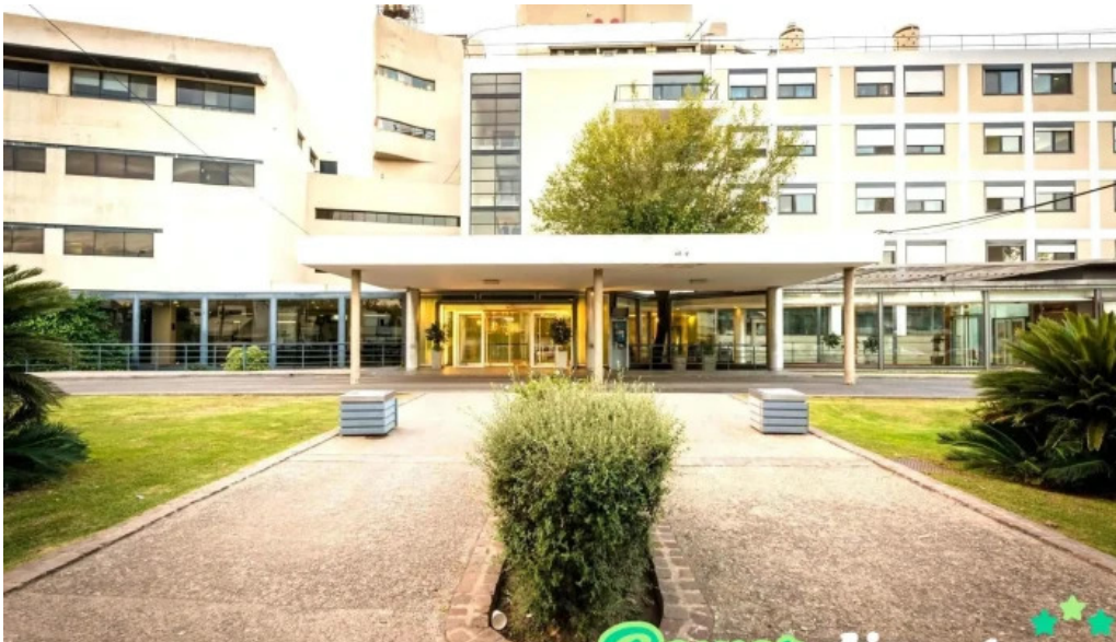
Hospital privado universitario de cordoba edificio
