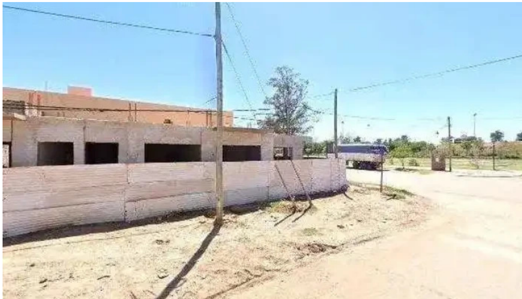
Kinesiologia y rehabilitacion direccion
