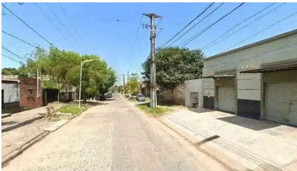
Centro integral de rehabilitacion telefonodeg
