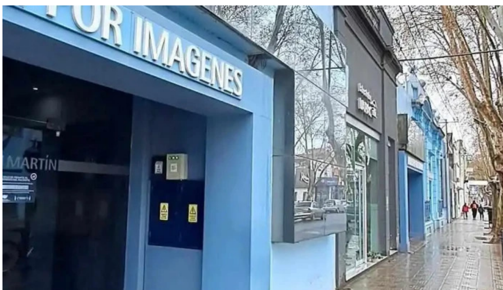
Clinica san martin edificio
