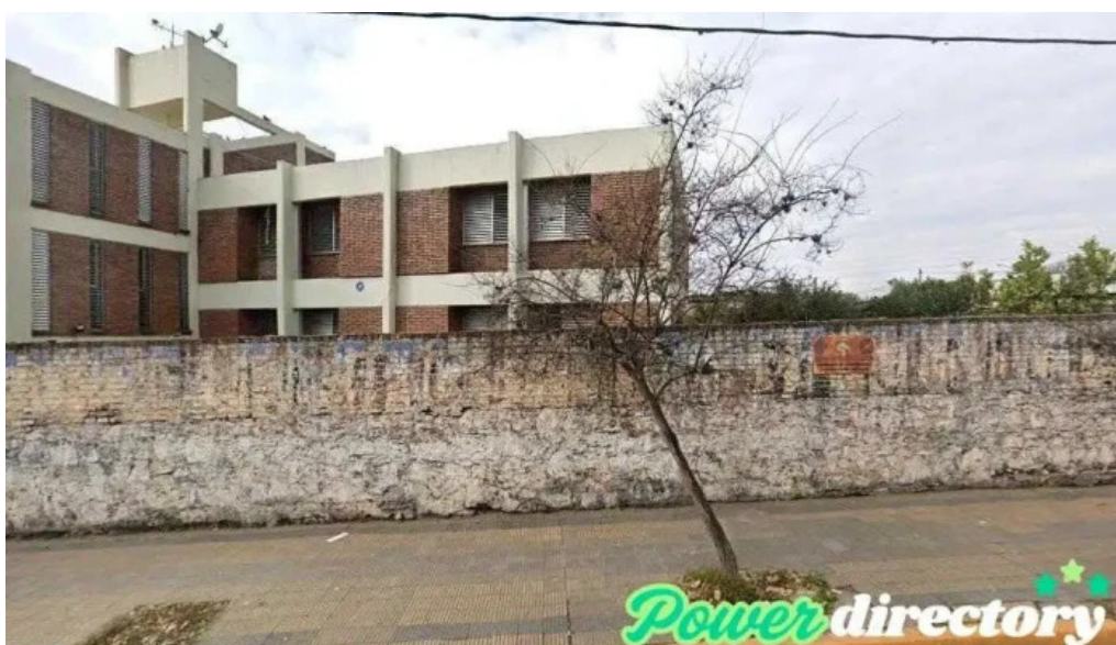
Casa luna centro de rehabilitacion alta gracia
