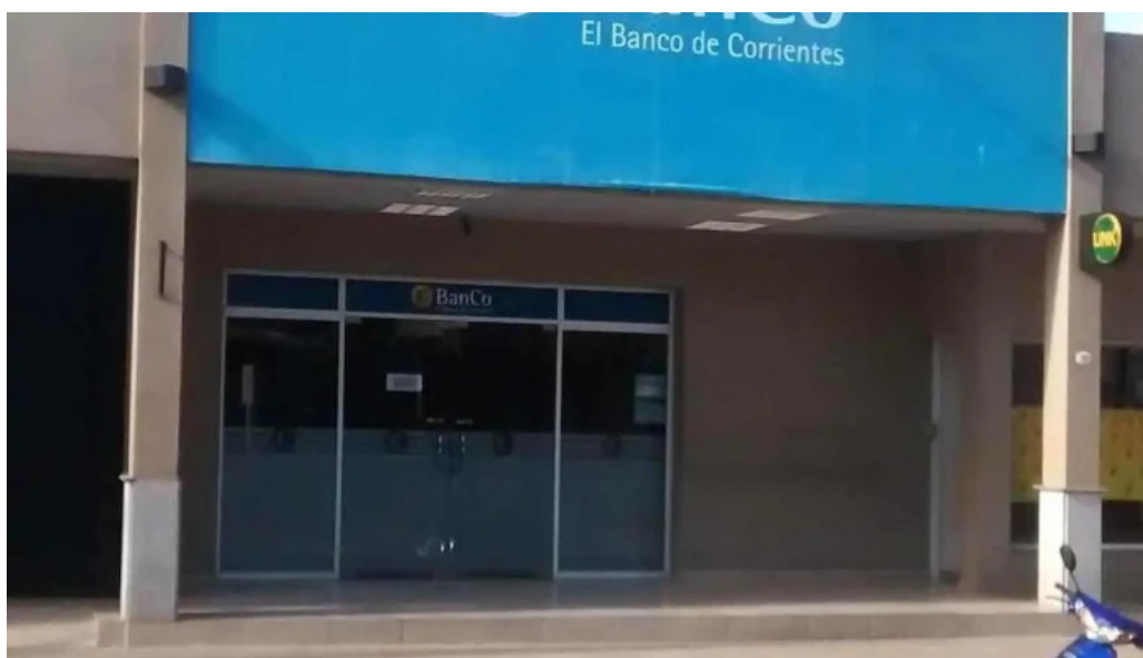
Banco de corrientes exterior
