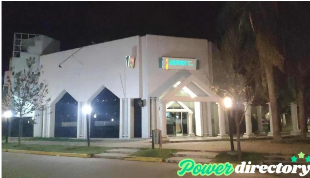
Bancor las varillas
