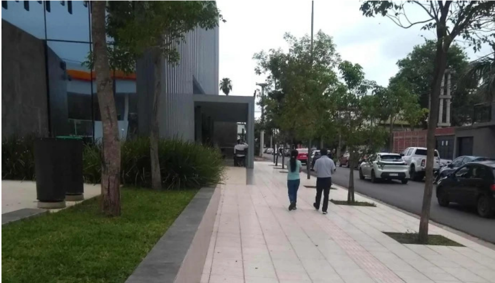
Banco de corrientes sa edificio administracion videos
