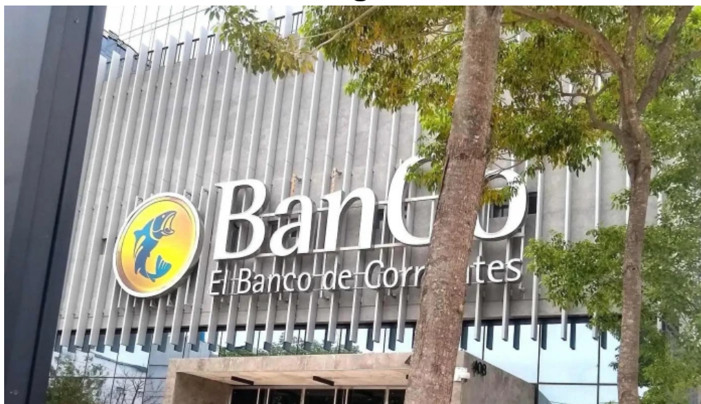
Banco de corrientes sa edificio administracion zona
