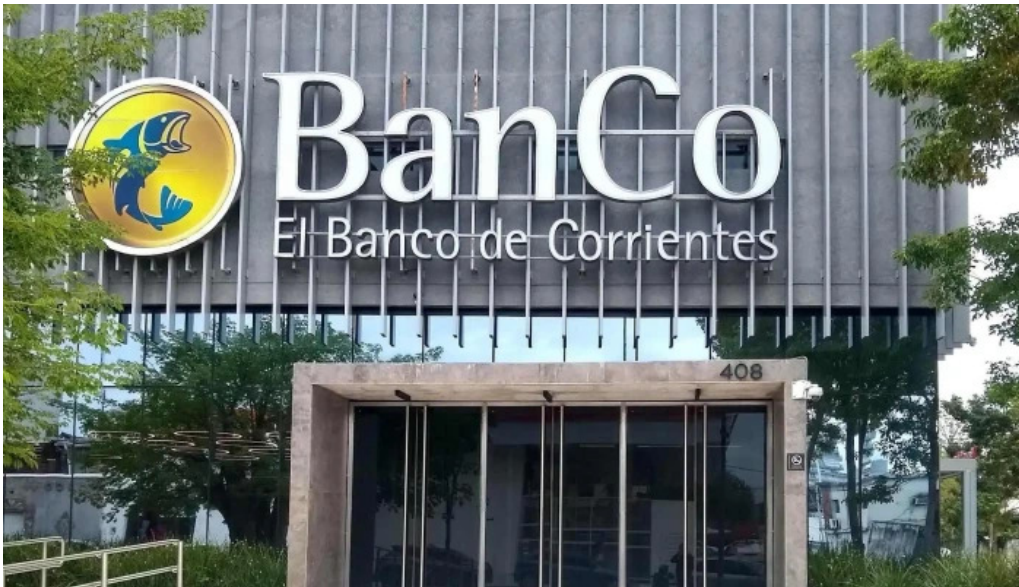
Banco de corrientes sa edificio administracion donde
