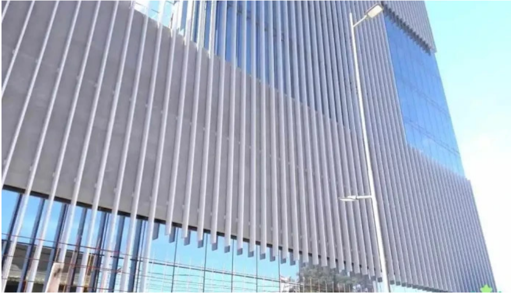
Banco de corrientes sa edificio administracion exterior
