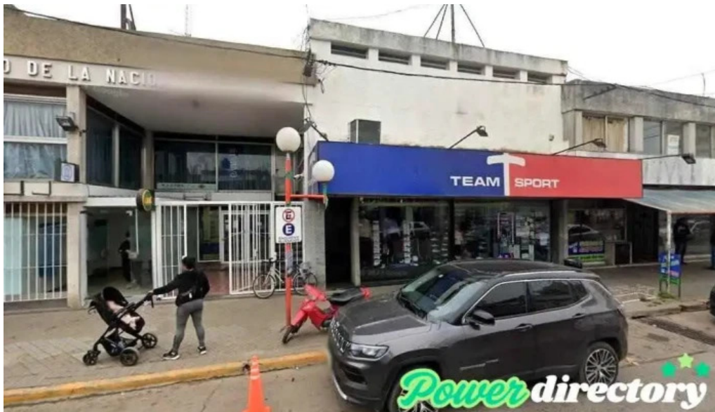
Banco de la nacion argentina arroyo seco
